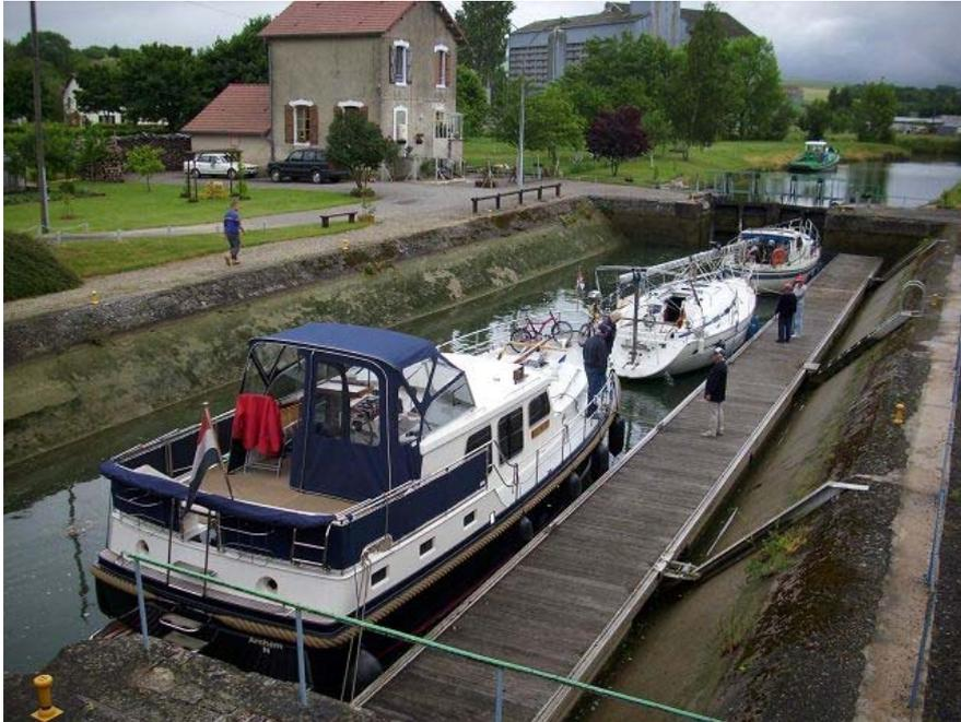
*Die früher berüchtigte Schleuse mit den schrägen Wänden in Consenvoye wurde durch den Einbau eines Schwimmsteges entschärft.*
